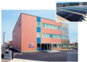
東海ガス藤枝本部
