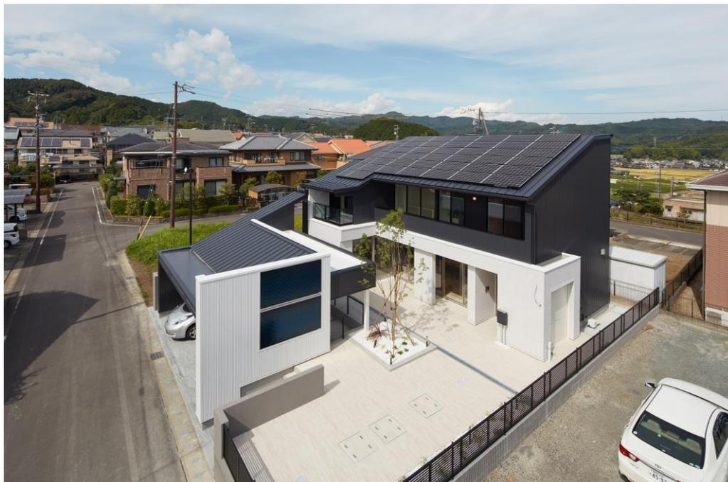
(写真1：OTSハウス全景をドローンにて撮影。一方向に傾斜した屋根と広い中庭で雨水を効率的に集水。
